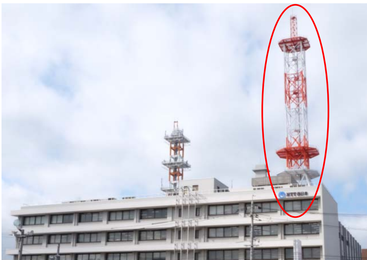
撤去する鉄塔(赤枠内) 1972年建設、鉄塔の高さ100m(地上から)
